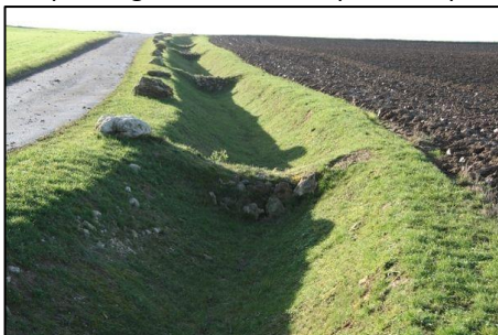
Exemple de noues s'intégrant aux aménagements routiers
