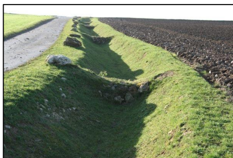
Exemple de noues s'intégrant aux aménagements routiers
