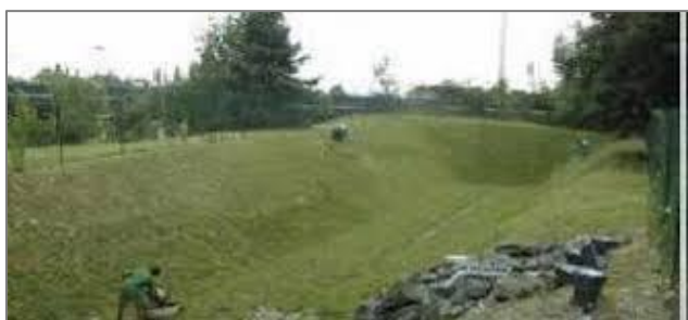
Exemples de bassins de rétention enherbés
