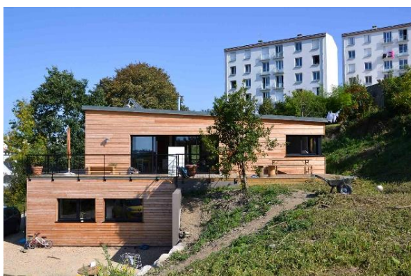
Principe de constructions dans la pente limitant la hauteur par rapport au terrain naturel sur l'amont
