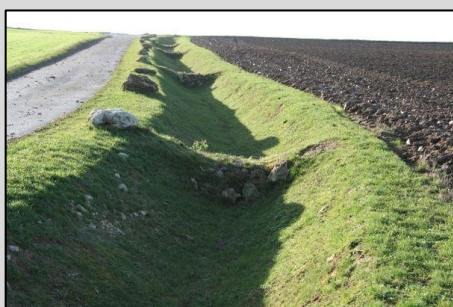
Exemple de noues s'intégrant aux aménagements routiers
