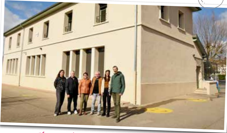
Février - Rénovation énergétique de l'école primaire
